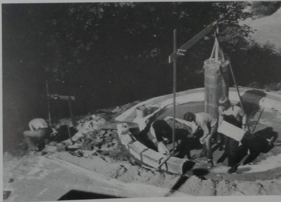
Bild 10. Die Kuppel wird mit einer Zirkellehre kreisrund gebaut
