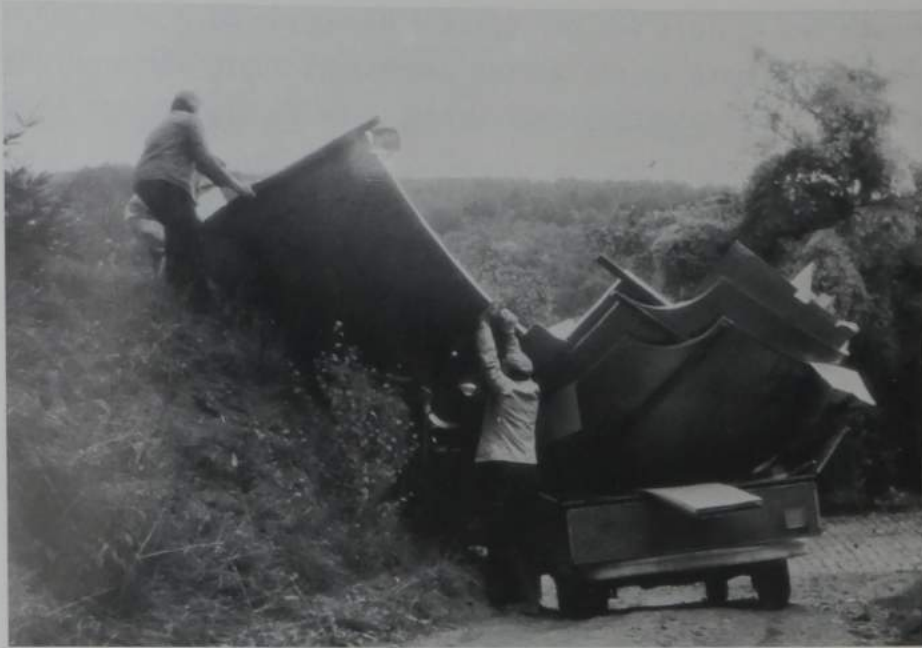
Bild 9. Die Polyester-Teile der Kuppel werden angeliefert
